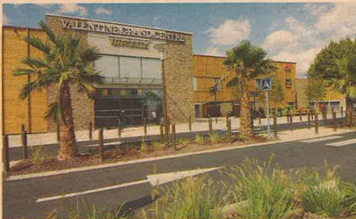
Au centre commercial Valentine de Marseille, bois et pierre sèche ont remplacé l'aluminium. DR
