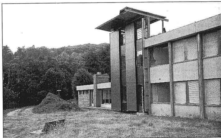
Une partie rénovée d'un bâtiment de l'ancien hôpital laisse présager de l'apparence future des locaux.
